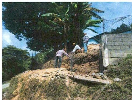
Foto 2: Mejoramiento de muro de contencion para resguardar la integridad fisica de los niños y niñas del establecimiento educativo.
