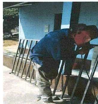
Foto 4: mejoramiento del cerco perimetral colocando baranda metalica para resguardar la integridad fisica de los niños y niñas de la etapa 4.
