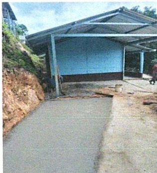
Foto 1: Mejoramiento de torta de cemento para que los niños y niñas tengan una superficie de piso evitando la tierra y el polvo.
